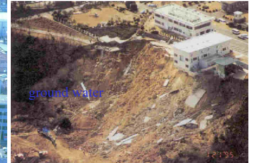
1995兵庫県南部地震: 西宮市仁川地すべり、死者: 34名
